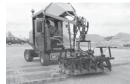
Verlegemaschine [Quelle: Mentlein 2014]
