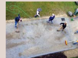
Einfügen und Einschlämmen des Fugensandes
