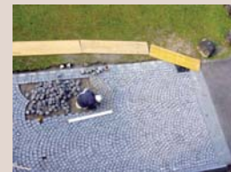
Setzen des Pflasters im Segmentbogen
