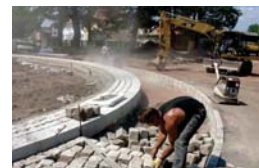
Bagger und Rüttelplatte
