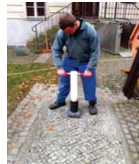
Verdichtung mittels Handramme
