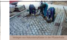
Verlegen von Natursteinpflaster in der Pflasterhalle
